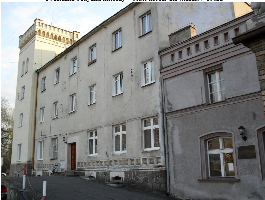
Fot. 4 Podziemia budynku mieściły w sobie karcer dla więźniów obozu
