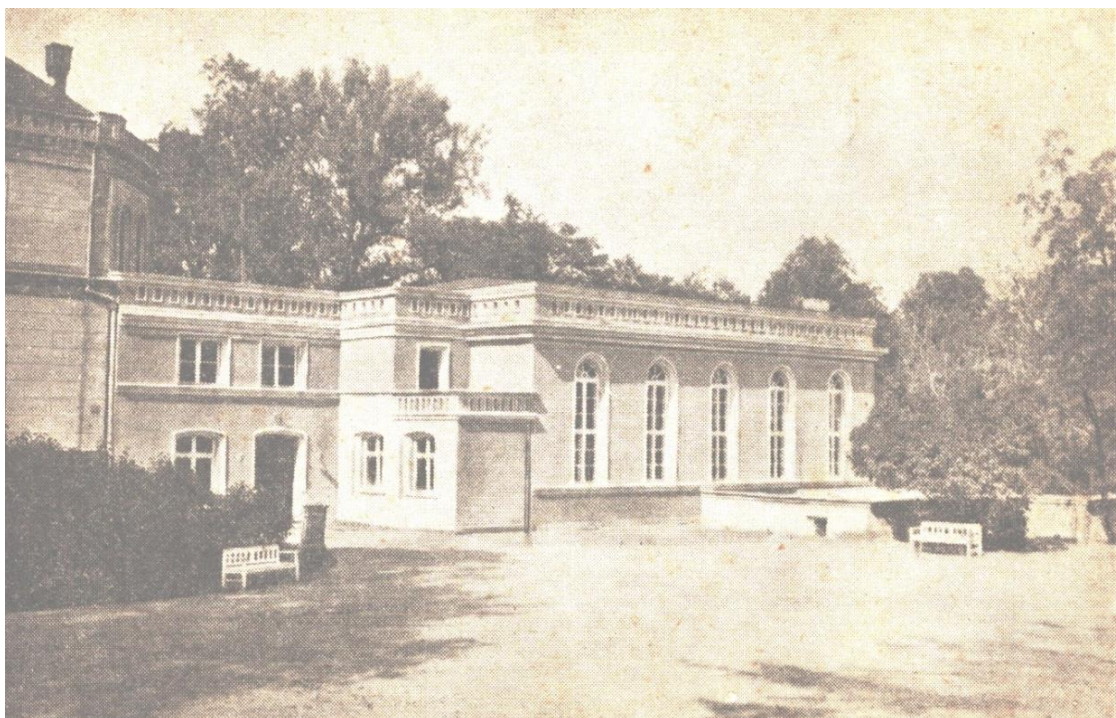
Ilustr. 79. Pałac w Potulicach k/Nakła nad Notecią. Widok na wsch. elewację budynku, dobudowanego do wsch. skrzydła pałacu, na fot. z terenu parkowego rozciągającego się po wsch. stronie pałacu, prawd. z 1 poł. XX w.. Źródło: ze zbiorów prywatnych Katarzyny Król, zamieszkałej w pałacu w Potulicach, 2019 r.
