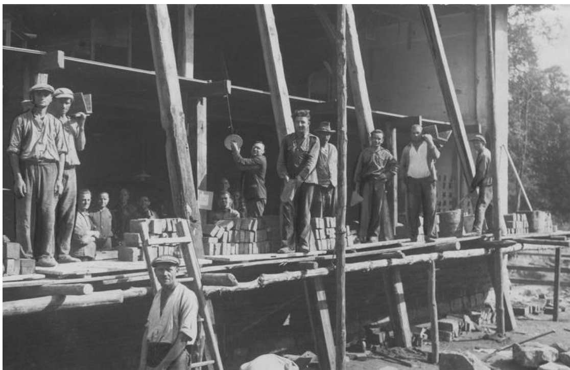
Ilustr. 102. Dom Rzemieślniczy w Potulicach k/Nakła nad Notecią. Bracia zakonnicy podczas pracy przy budowie budynku Domu Rzemieslniczego, na fot. z 1933 r.; źródło: Narodowe Archiwum Cyfrowe
