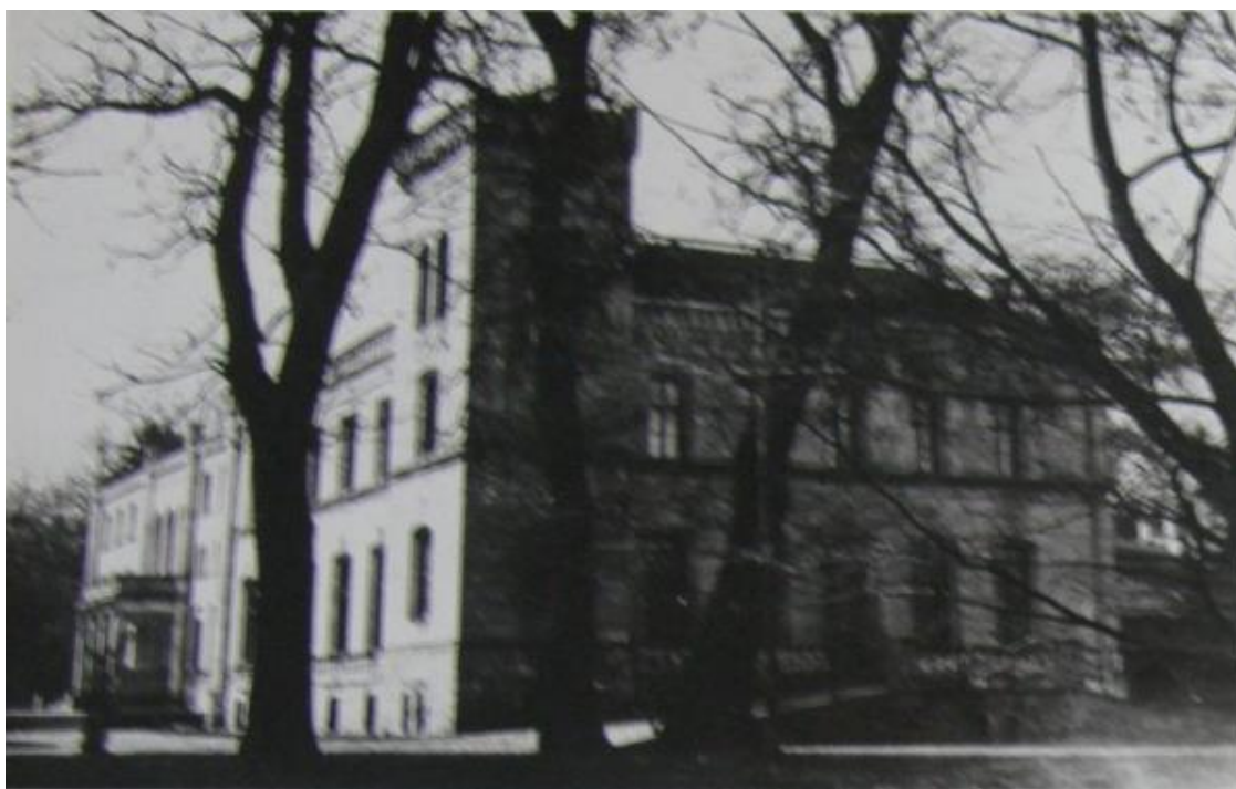
Ilustr. 78. Pałac w Potulicach k/Nakła nad Notecią. Pałac w widoku na elewację frontową, wieżę w pd-wsch. narożniku skrzydła wschodniego pałacu i na elewację wschodnią ww. skrzydła, na fot. prawd. z początku XX w. Źródło: ze zbiorów prywatnych p. Teresy Kasprzak, mieszkającej w historycznym czworaku, należącym pierwotnie do majątku w Potulicach, 2019 r.
