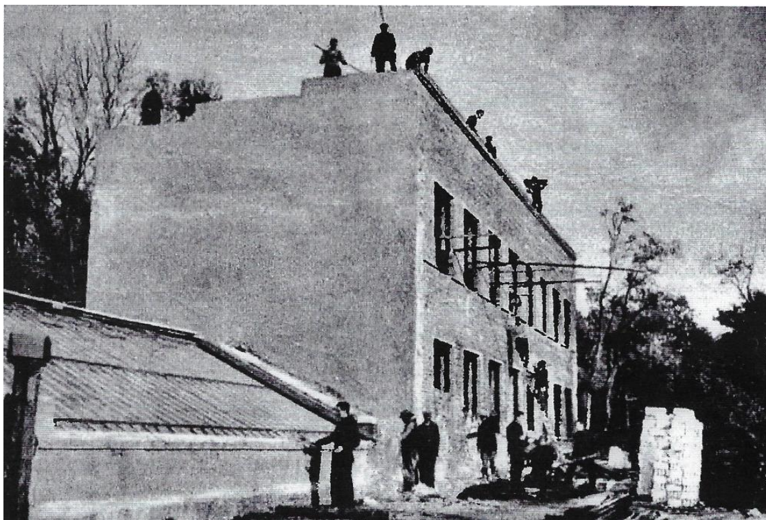
Ilustr. 103. Dom Rzemieślniczy w Potulicach k/Nakła nad Notecią. Bracia zakonnicy podczas pracy przy budowie budynku Domu Rzemieslniczego, na fot. z lat 30-tych XX w. Z lewej strony istniejąca jeszcze wówczas palmiarnia. Fotografia pochodzi z książki Z. Greinerta „ Potulice, Ślesin i okolice. Historia dotąd nieznana do roku 1945 , s. 307
