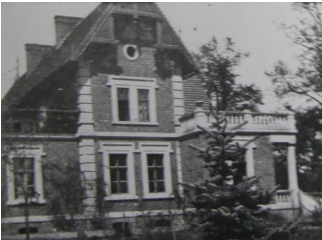
Ilustr. 150. Dom Administracji majątności Potulice k/Nakła nad Notecią, w widoku od strony południowej, na fot. z I. 20-tych XX w., źródło: z prywatnych zbiorów p. Teresy Kasprzak, mieszkającej w historycznym czworaku, należącym pierwotnie do majątku w Potulicach, 2019 r.
