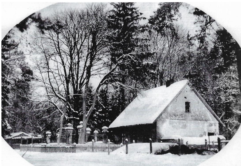
Ilustr. 157. Zespół pałacowo-parkowy w Potulicach, gm. Nakło nad Notecią. Zabudowania mieszkalne po bokach głównej bramy wjazdowej na teren posiadłości potulickiej, przy drodze z Bydgoszczy do Nakła nad Notecią, w widoku od strony pd-wsch., na fot. z lutego 1929 r. wyk. przez Zofię Radziwińska, córkę dyrektora Administracji Majętności Potulice , zamieszczonej w książce Zenona Greinerta „Potulice, Ślesin i okolice Historia dotąd nieznaną do roku 1945”, str. 252
