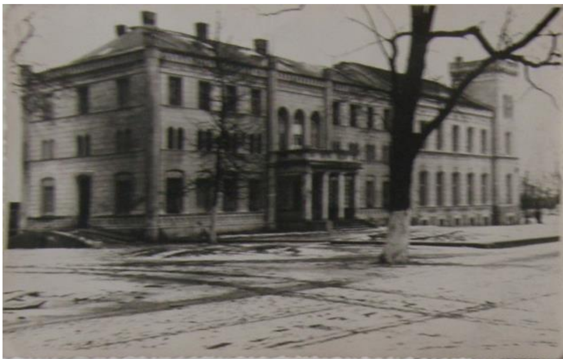
Ilustr. 82. Pałac w Potulicach k/Nakła nad Notecią. Widok na pałac w ujęciu od strony pd-zach. w kierunku fasady budynku i zachodniego szczytu korpusu pałacu, na fot. prawd. krótko po II wojnie światowej, źródło: Kadr z filmu IPN Bydgoszcz pt. „Obóz przesiedleńczy i pracy przymusowej Potulitz”, filmoteka You Tube
