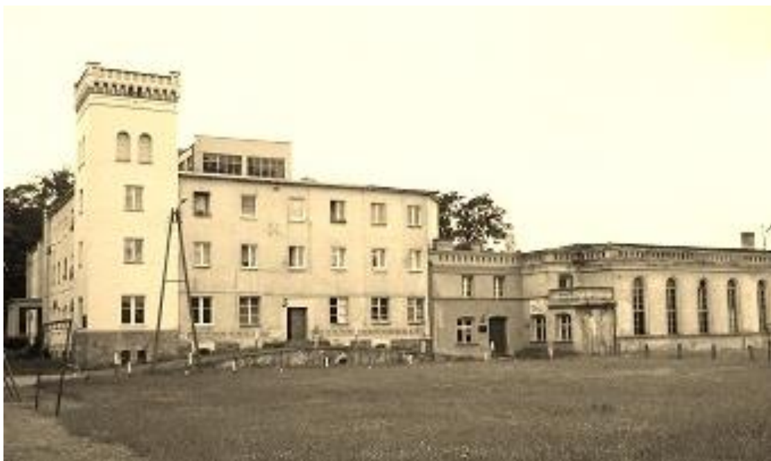
Ilustr. 80. Pałac w Potulicach k/Nakła nad Notecią. Widok z polany parkowej po wsch. stronie pałacu na wieżę w pd-wsch. narożniku skrzydła wschodniego pałacu, na wsch. elewację ww. skrzydła i dobudowaną do niego od pn. salę (prawd. pierwotna oranżeria), na fot. prawd. z I. 60-tych XX w., źródło:
