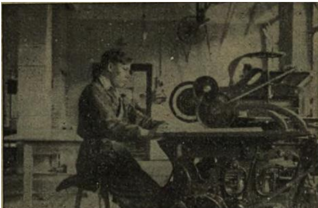
Ilustr. 115. Dom Rzemieślniczy w Potulicach k/Nakła nad Notecią - jedno z pomieszczeń Zakładu Poligraficznego, na fot. z I. 30-tych XX w., z maszyną, przez którą przechodził każdy arkusz kalendarza; źródło: Kalendarz Królowej Wychodztwa Polskiego na rok 1938, Rocznik III
