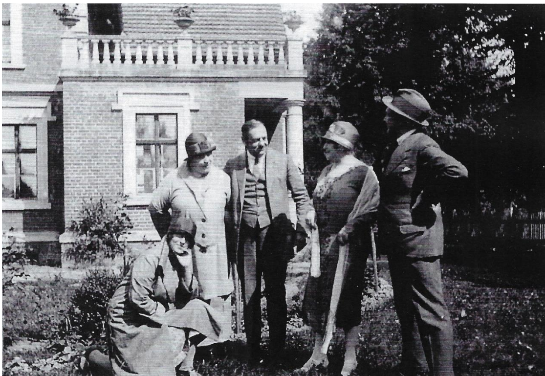
Ilustr. 154. Dom Administracji majątności Potulice k/Nakła nad Notecią, w widoku od strony południowej, na fot. z ok. 1932 r. Z lewej strony w głębi widoczne ogrodzenie, prawd. z drewnianych sztachet. Na pierwszym planie od lewej: Zofia Radzimińska, córka dyrektora Administracji Majętności Potulice, dalej – jej rodzice Janina i Stefan Radzimińscy oraz goście z Poznania – Aleksandra Motty z d. Lichodziejewska i Marceli jr. Motty., źródło: książka Zenona Greinerta „Potulice, Ślesin i okolice. Historia dotąd nieznana do roku 1945, Bydgoszcz 2014, s. 287
