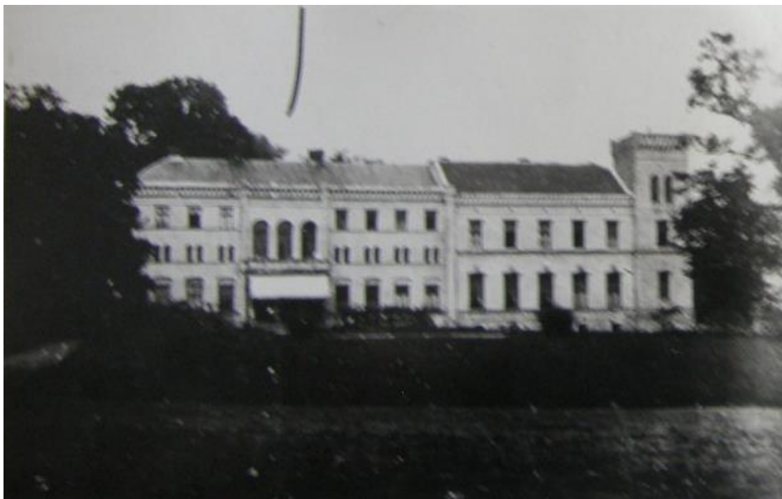
Ilustr. 57. Pałac w Potulicach k/Nakła nad Notecią. Widok na elewację frontową z polany parkowej na wprost fasady budynku, na fot. prawd. z 1 poł. XX w. Ze zbiorów prywatnych p. Teresy Kasprzak, mieszkającej w historycznym czworaku, należącym pierwotnie do majątku w Potulicach, 2019 r.
