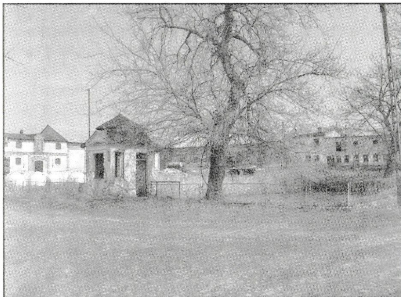
Podwórze gospodarcze w Potulicach z widoczną na pierwszym planie wagą wozową. Wewnątrz zachował się jeszcze cały mechanizm wążący. Fot. z arch. MZK.
