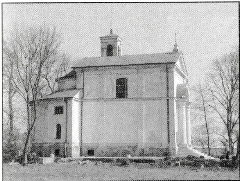
Kaplica w Potulicach. Elewacja zachodnia. Fot. z arch. MZK.
