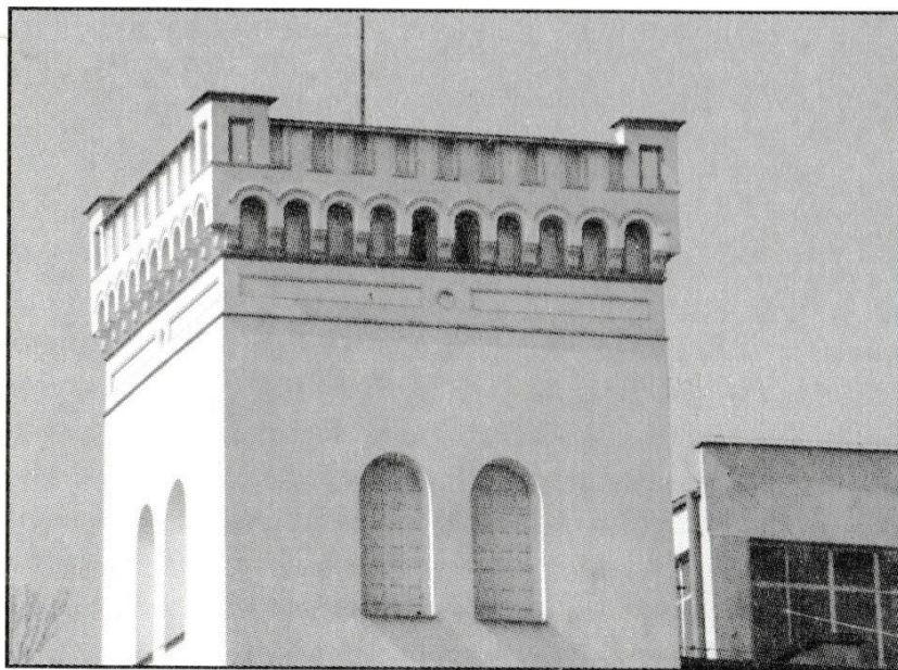
Charakterystyczna wieża pałacu, zakończona krenelażem czyli zębatym blankowaniem. Fot. z arch. MZK.
