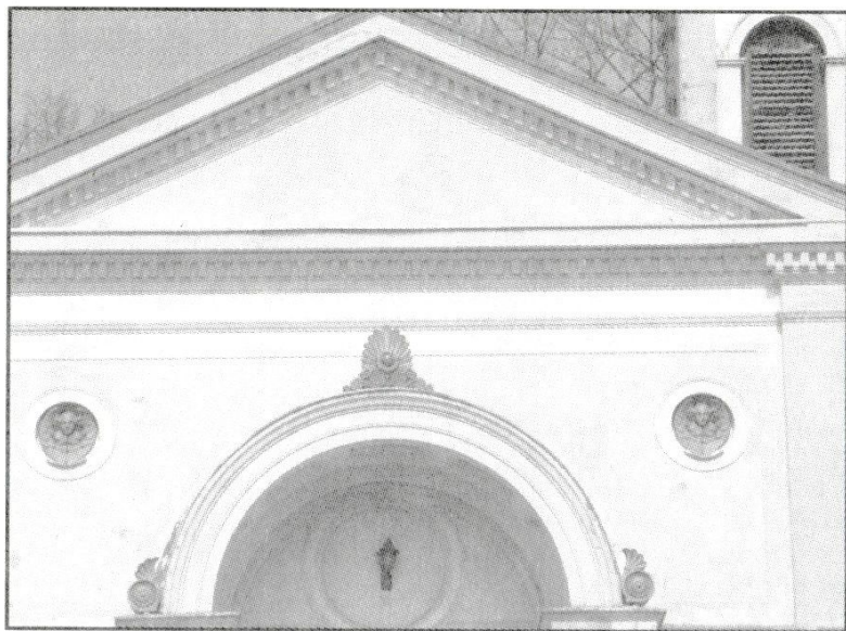
Trójkątny naczółek wieńczący główne wejście do kaplicy. Poniżej widoczne elementy zdobnicze. Fot. z arch. MZK.
