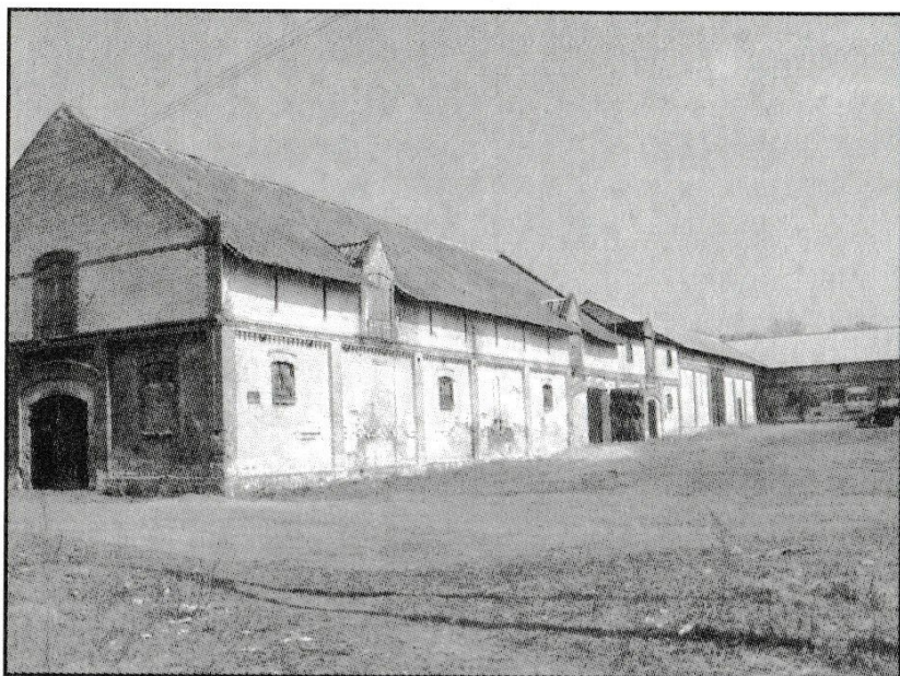
W północno-zachodniej części podwórza gospodarczego stoi stajnia, zbudowana w 1910 r. Jedną z elewacji styka się ze stodołą. Fot. z arch. MZK.
