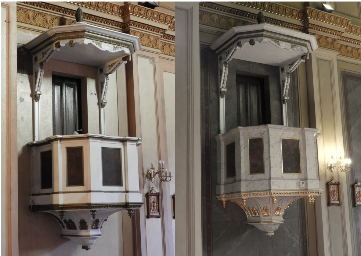
Ambona przed i po renowacji.
